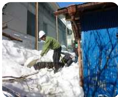
氷川中学校体育館から落ちた雪の除雪作業(長畑地区)
