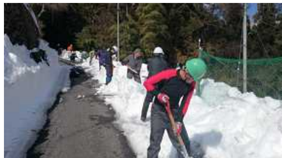
拡幅作業 救急車等の緊急車両が通行できる幅まで除雪しました(峰地区)
